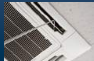
空調機器の能力試験・保守点検
