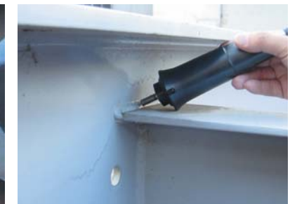
●溶接部の溶接強度測定 (引張強度の確認)
