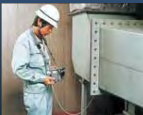
ダクト内の風速・静圧測定に
