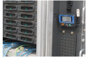
サーバールームの温湿度記録
